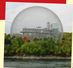
Estructura de la cúpula geodésica diseñada por Buckminster Fuller.
